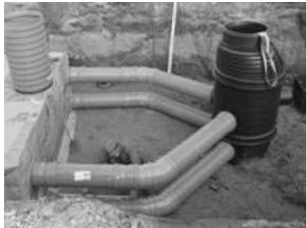
Фиг. 42: Монтиране на успоредни входове и Тегра 1000 с човешки достъп
