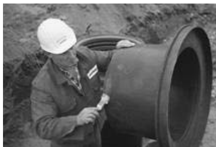
Фиг. 37: Нанасяне на силиконова смазка
