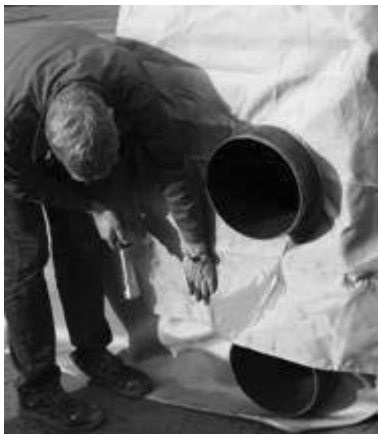
Фиг. 16: Припокриване на входен преход с накрайник от геотекстил
