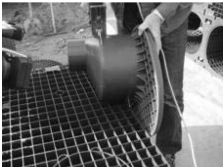
Фиг. 15: Изрязване на място на входния преход до DN315
