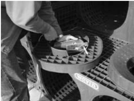
Фиг. 28: Изрязване на втория коничен преход чрез трион
