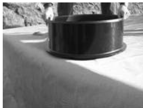
Фиг. 34: Монтиране на прехода към шахта Тегра 600
