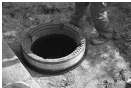
Фиг. 39: Нанасяне на силиконова смазка
