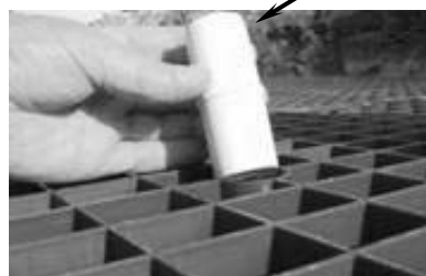
Фиг. 13: Правилно поставяне на вертикална връзка
