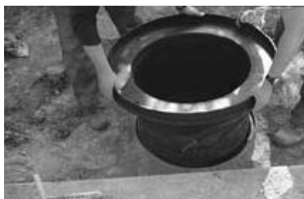
Фиг. 38: Нанасяне на силиконова смазка
