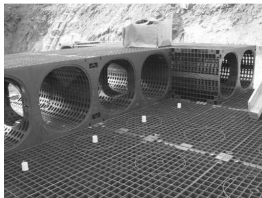
Фиг. 11: Монтирани вертикални връзки
