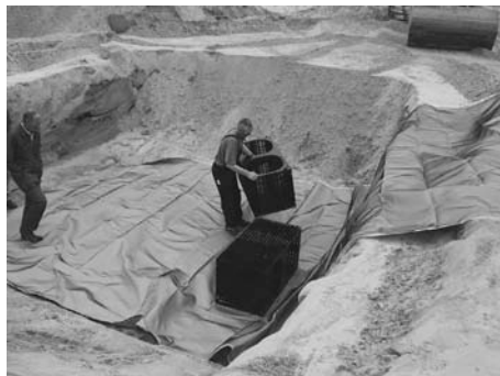
Фиг.2: Постилане на руло геотекстил
