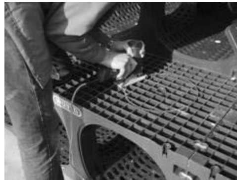
Фиг. 20: Изрязване на отвор в мястото с кръгова маркировка чрез вертикален трион
