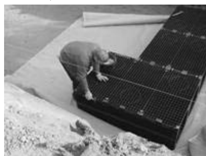
Фиг. 7: Последователно нареждане на дренажни модули
