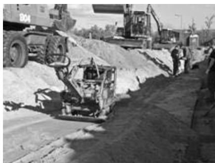
Фиг. 44: Трамбоване на пластове през 20 см
