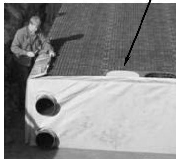
Фиг. 33: Общ изглед към монтиран тежък накрайник
