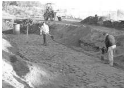
Фиг. 43: Трамбоване чрез вибро - плоча
