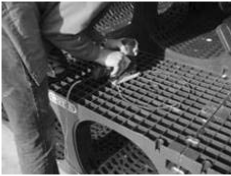
Фиг. 27: Изрязване на отвор в мястото с кръгова маркировка чрез вертикален трион
