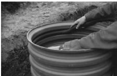
Фиг. 36: Полагане на уплътнителния пръстен
