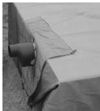
Фиг.6: Монтирано платно с припокриване (страничен изглед)
