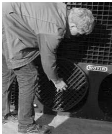
Фиг. 14: Пример за монтиране на крайник
