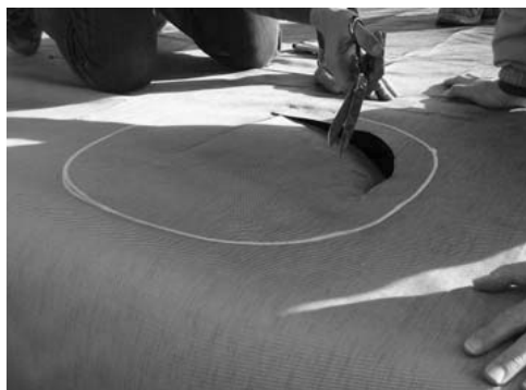
Фиг. 22: Предварително маркиране на покритието и последващо изрязване на 5 см отвътре
