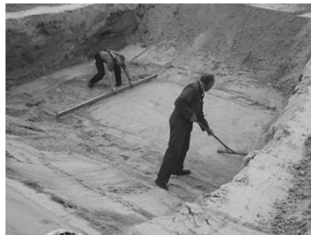
Фиг. 1: Подравняване на пясъчното легло
